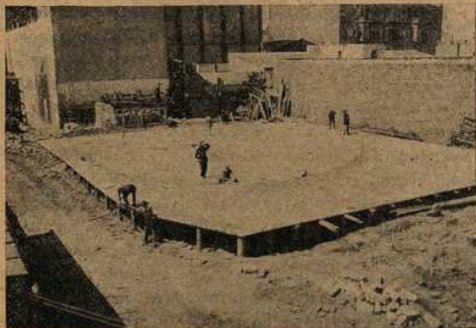
Рис. 70. Поворотная площадка для киносъемок на фабрике Азгоскино (ныне Азеркино) в Баку.
