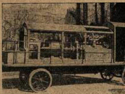
Рис. 64. Передвижная электростанция („лихтваген“) для подсвечки „на натуре“, построенная Ленинградской фабрикой Совкино (мотор 125 л. с., динамомашинна — 650 ампер).
