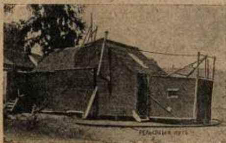
Рис. 48. „Черная Мери“ Эдиссона в Орэндж возле Нью-Йорка. Все ателье могло вращаться по рельсовому пути.
