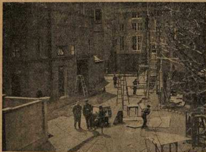
Рис. 68. Постройка декорации улицы из фундамента по системе С. В. Козловского на площадке фабрики „Межрабпомфильм“ в Москве.
